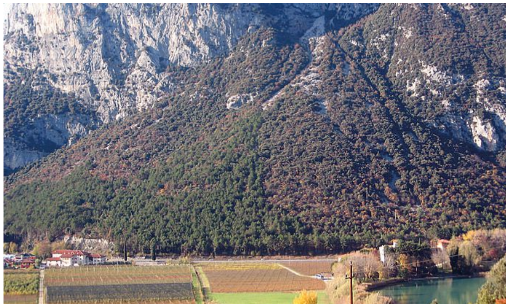
La vistosa frana, coperta da vegetazione, che incombe sull'abitato di Sarche e sulla Gardesana
